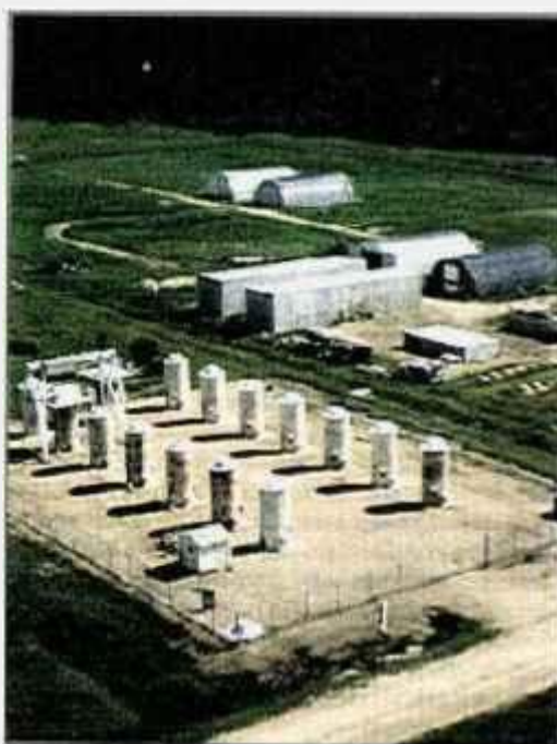
Figura 1.3: Fotografias de repositórios temporário para rejeitos radioativos do tipo “silo” (8) .
