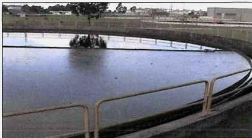
Figura 3.9: - Sistema de decantação secundária da ETE de Barueri.
