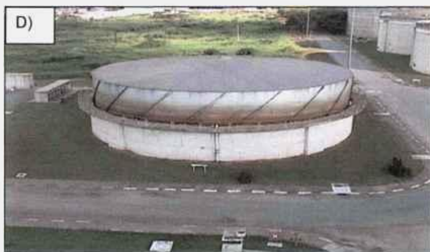
Figura 3.11: - C) digestores do lodo produzido na ETE de Barueri; D) gasômetro.
