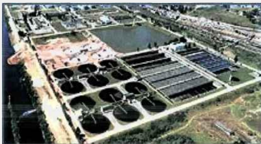
Figura 3.2: - Foto panorâmica das instalações da ETE de Barueri – SP.
