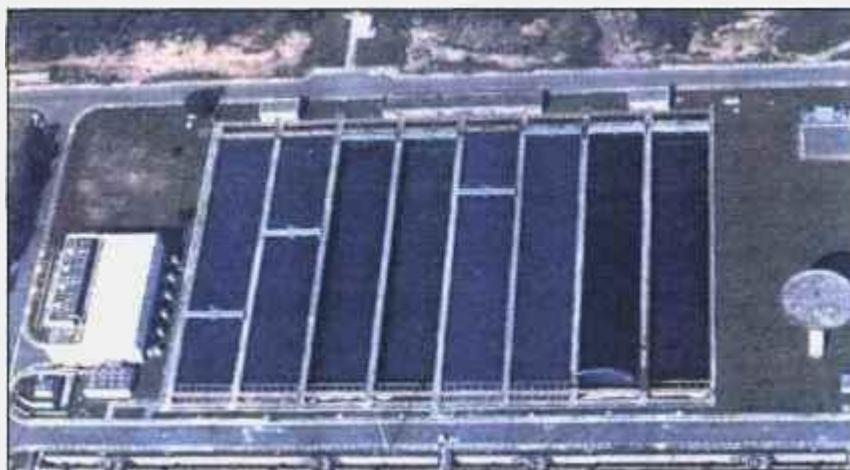
Figura 3.7: - Conjunto de decantadores primários da ETE de Barueri.
