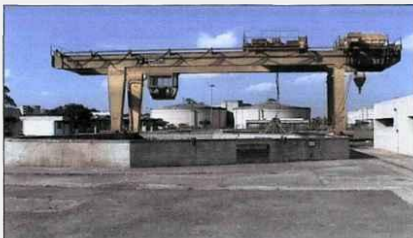
Figura 3.5: - Poço distribuidor e elevatório final da ETE de Barueri.
