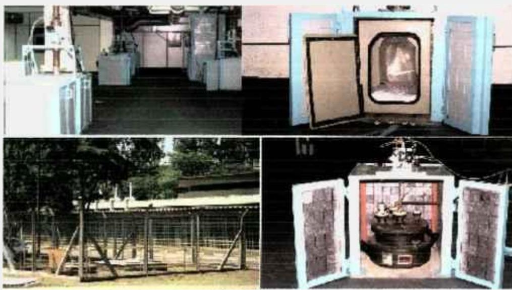
FIGURA 3.2 (b) - Instalação do Centro de Radiofarmácia (CR) do IPEN
