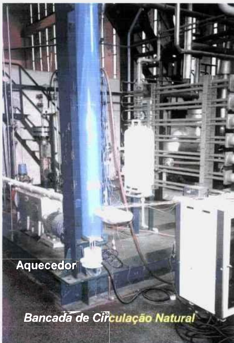
Figura 8 – Aquecedor da Bancada de Circulação Natural
