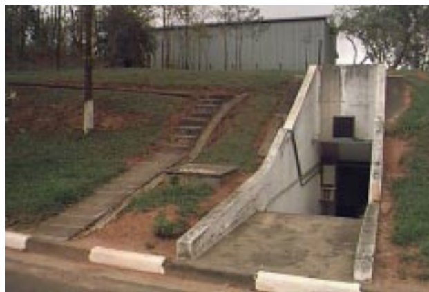
Figura 1. Entrada principal do bunker de calibração do LCI/IPEN/CNEN-SP.
