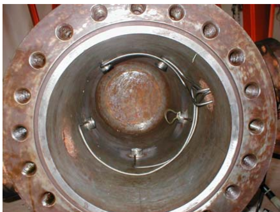
Após instalação dos extensômetros
