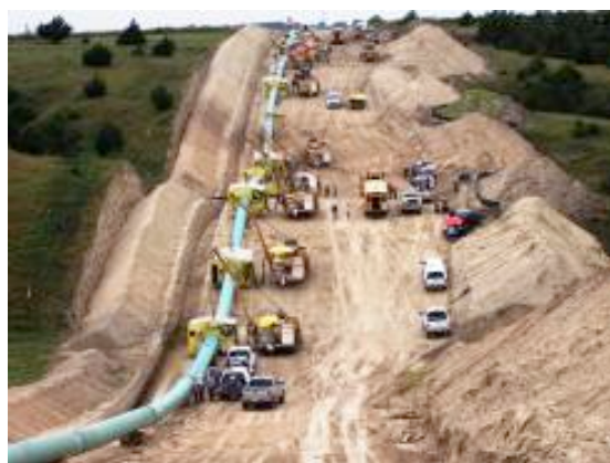
Figura 1 - Soldagem em campo, REX Pipeline, EUA. Fonte: Price Gregory
