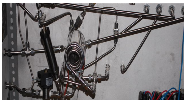
Figura 2: Construção das Tubulações de gás do sistema
