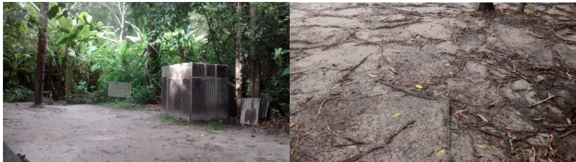
Figura 7: Raízes expostas na área próxima ao atrativo Fervedouro das Bananeiras. Figure 7: Roots exposed in the area near the attractive Fervedouro das Bananeiras. Fotos: Dutra (2016). Photos: Dutra (2016).
