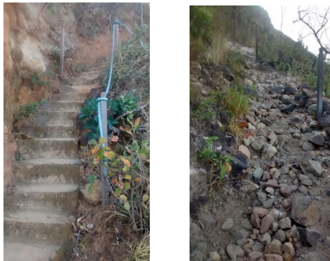
Figura 13 e 14: Trecho da trilha com estrutura. Figure 13 and 14: Track section with structure. Fotos: Dutra (2016). Photos: Dutra (2016).
