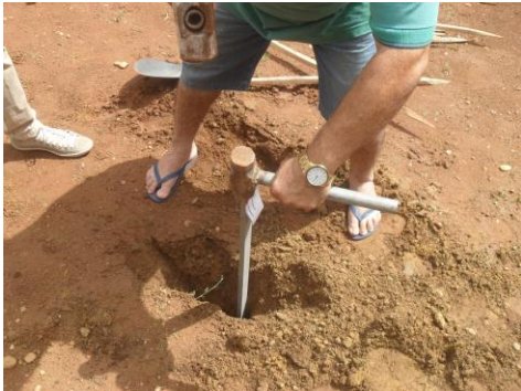
Figura 04 – Cravação das hastas metálicas
