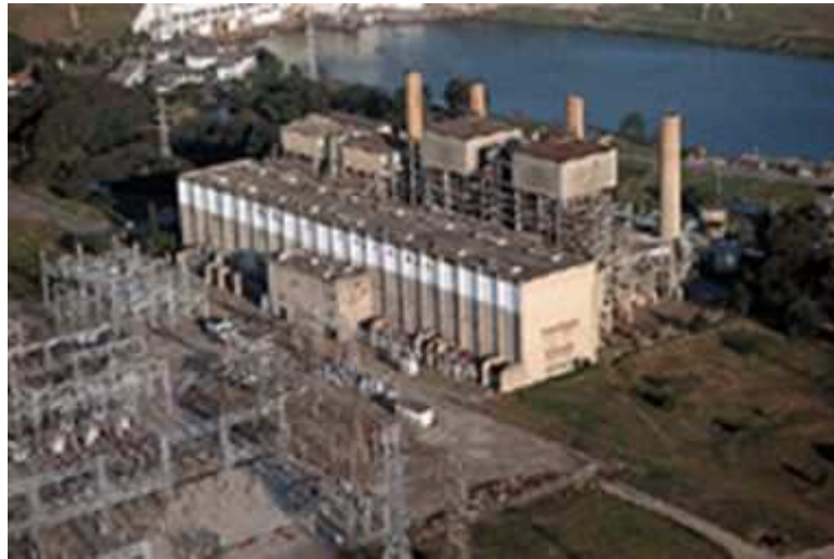
FIG. 5. Piratininga - AES Eletropaulo Thermal Power Plant (470MW).
