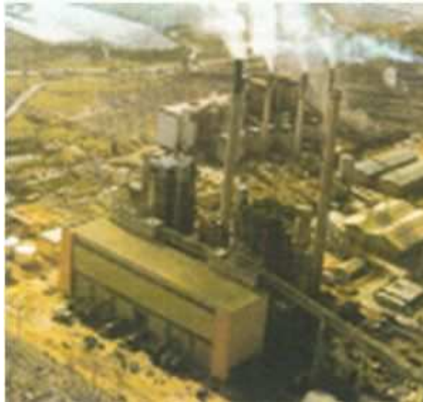
FIG. 3. Jorge Lacerda - ELETROSUL Thermal Power Plant (823MW).
