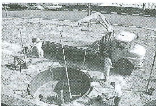
Figura 3. Escavação da Piscina do Irradiador Multipropósito de Cobalto-60 tipo Compacto.
