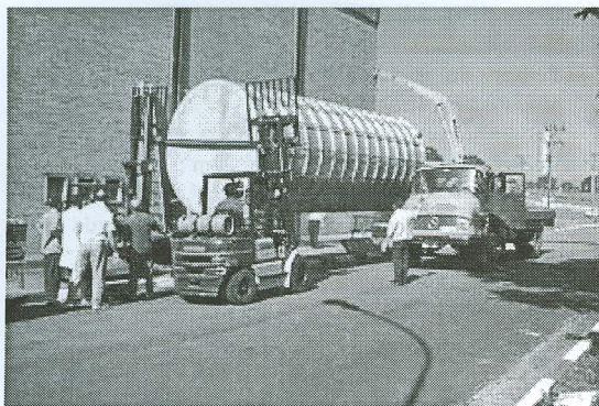
Figura 2. Liner da Piscina de Armazenamento de Fontes Radioativas do Irradiador Multipropósito de Cobalto-60 tipo Compacto.
