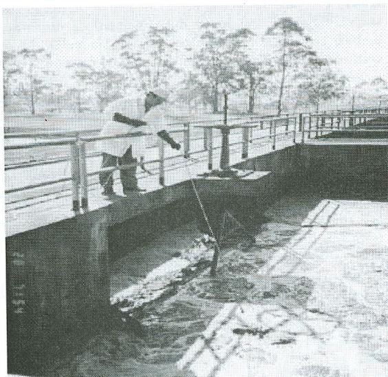
Figura 3. Instalação da Sonda Cintiladora na Saída do Tanque A [1]
