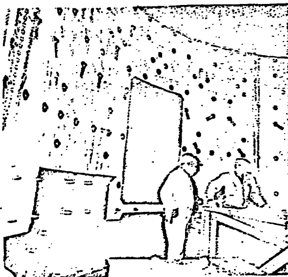
FIG. 1.9. - Instalação do Isolamento Cerâmico interno à parede do VPC do MCR de Fort. St. Vrain .
